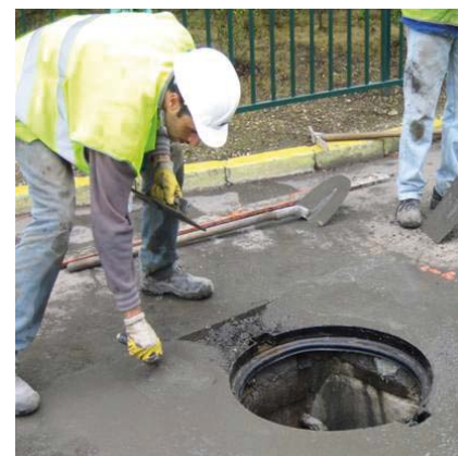
Montaż kręgu studzienki przy pomocy PCI Repafast® Tixo.
