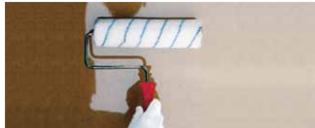
Nakładanie materiału gruntującego wałkiem ze średnim włosiem
