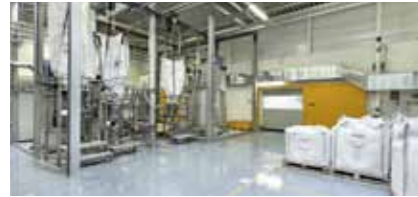
Posadzki Sikafloor® w halach przemysłowych i pomieszczeniach produkcyjnych
