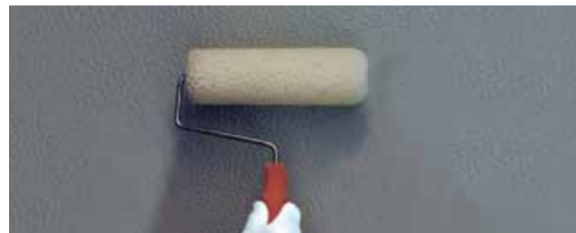
Aplikacja Sikafloor®-264 Thixo wałkiem strukturalnym.
