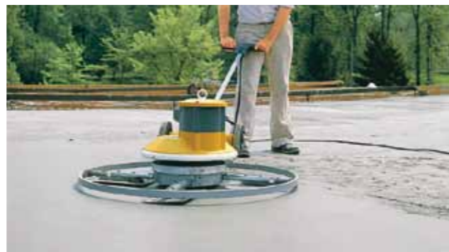
Mechaniczna zacieraczka z regulacją obrotów do zacierania posadzek cementowych i żywicznych.
