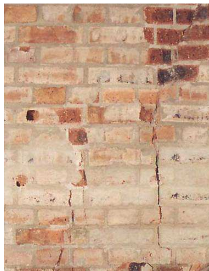
Rys. 2. Zarysowania ściany spowodowane wyczerpaniem nośności na ściskanie
