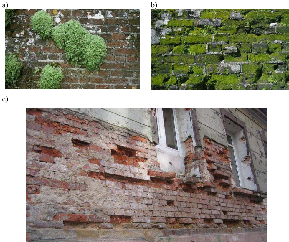
Rys. 36. Uszkodzenia elewacji spowodowane brakiem doraźnych remontów: a) wyrastająca z muru roślinność, b) mech na elementach murowych, c) uszkodzenia tynku, cegieł i spoinowania
