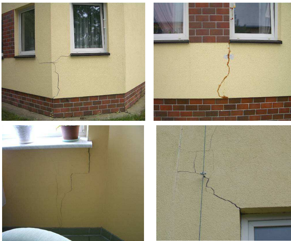
Rys. 17. Przykłady uszkodzeń ścian spowodowanych nierównomiernym osiadaniem podłoża gruntowego
