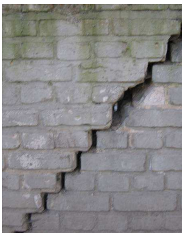
Rys. 43. Uszkodzenia od obciążeń wyjątkowych: a) trzęsieniem ziemi, b) i c) wpływami eksploatacji górniczej, d) powodzią
