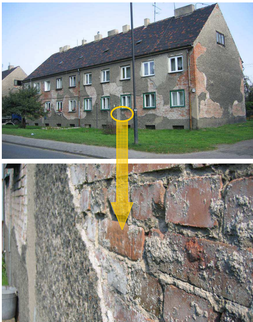
Rys. 45. Przykład odspojień tynku na skutek niewykonania obrzutki
