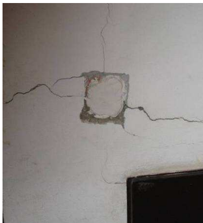
Rys. 24. Przykłady zarysowań ścianek działowych
