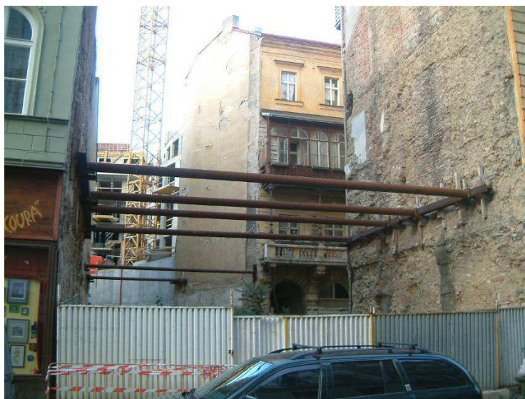
Rys. 42. Zabezpieczenie sąsiednich budynków po wyburzeniu budynku środkowego
