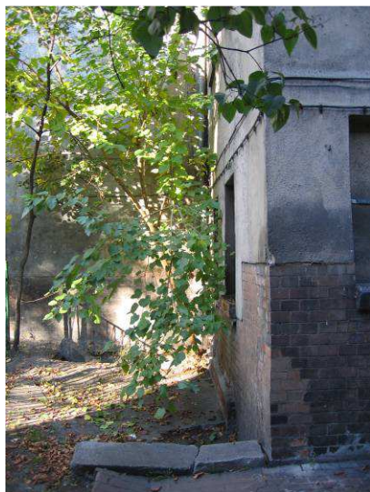
Rys. 39. Drzewa jako przyczyny uszkodzeń murów: a) drzewo wyrastające z okolic fundamentu, b) samosiejki wyrastające z murów
