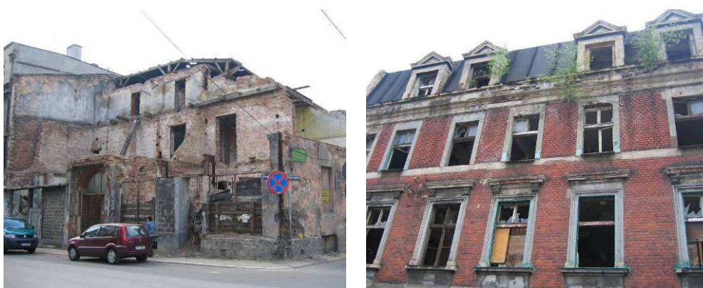
Rys. 37. Całkowita degradacja konstrukcji
