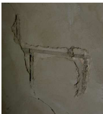
Rys. 29. Odkrywka tynku przy rysie – złe przewiązanie elementów murowych
