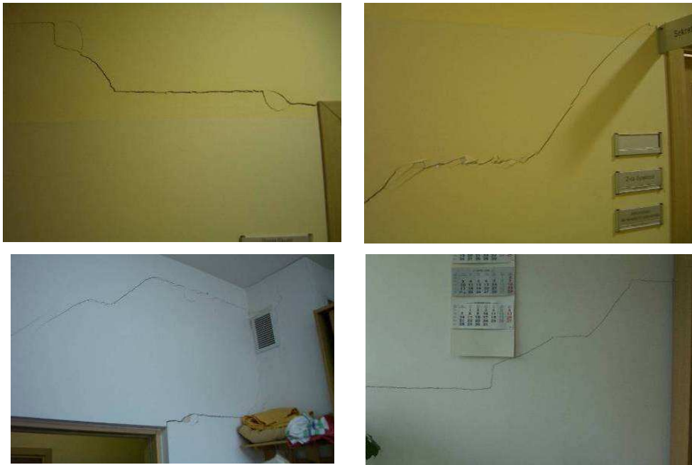
Rys. 35. Zarysowania na skutek ścięcia ścian działowych
