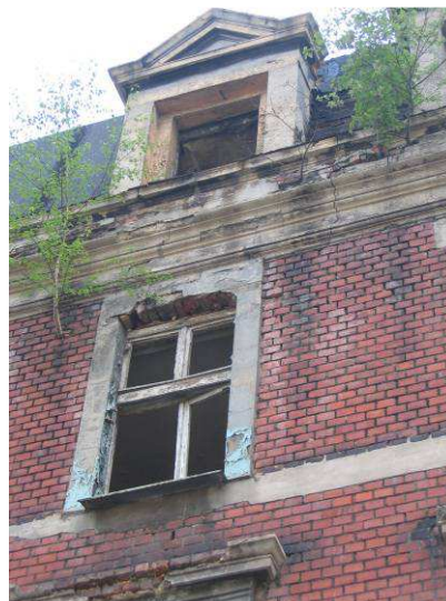
Rys. 39. Drzewa jako przyczyny uszkodzeń murów: a) drzewo wyrastające z okolic fundamentu, b) samosiejki wyrastające z murów
