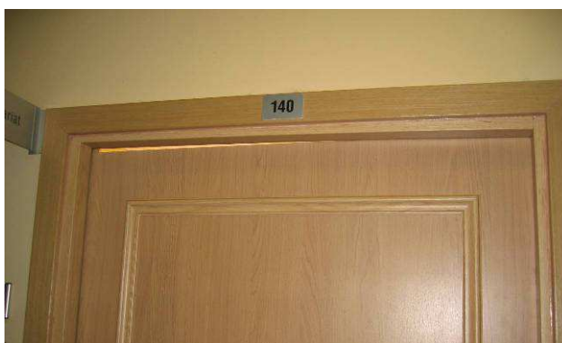
Rys. 34. Szczelina między skrzydłem drzwiowym a ościeżnicą powstała na skutek odkształceń ścian
