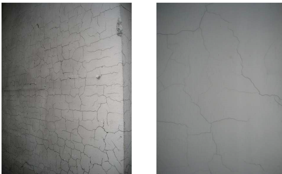
Rys. 44. Przykłady nieregularnych rys włoskowatych na tynku
