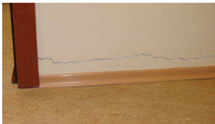
Rys. 19. Pozioma rysa w dolnej części ściany
