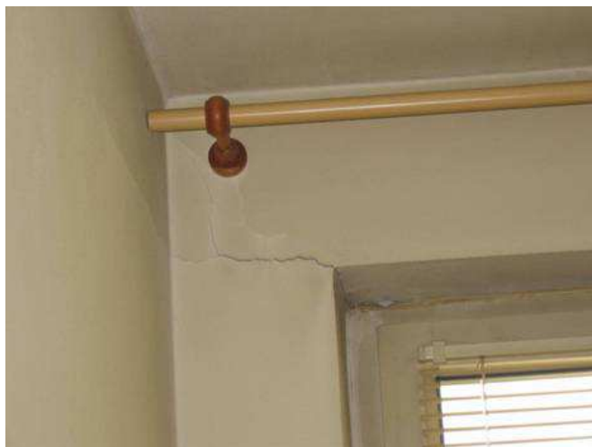
Rys. 6. Zarysowanie przy prefabrykowanym nadprożu
