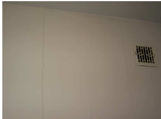
Rys. 13. Rysy wzdłuż przewodu kominowego
