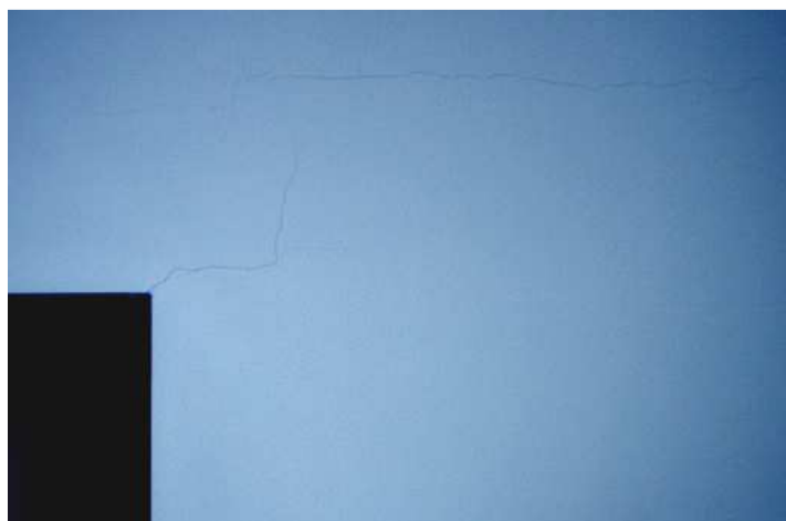
Rys. 22. Zarysowanie w rejonie naroży otworu drzwiowego
