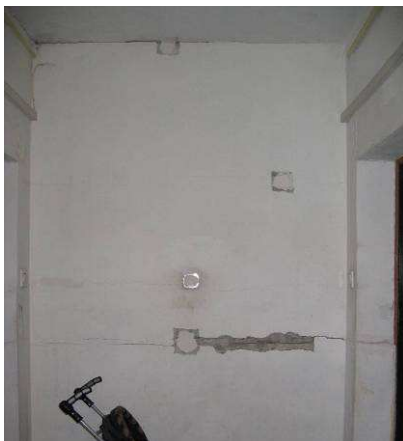
Rys. 24. Przykłady zarysowań ścianek działowych
