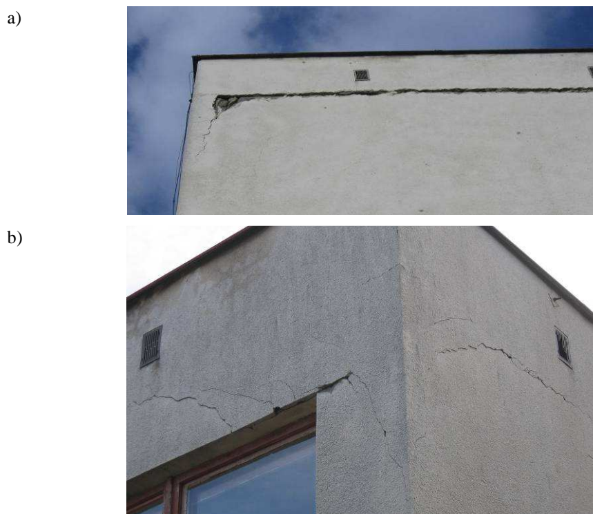
Rys. 11. Przykłady zarysowań spowodowanych odkształceniami termicznymi stropodachu: a) ściana bez otworów, b) narożnik ściany z oknami i ściany bez otworów
