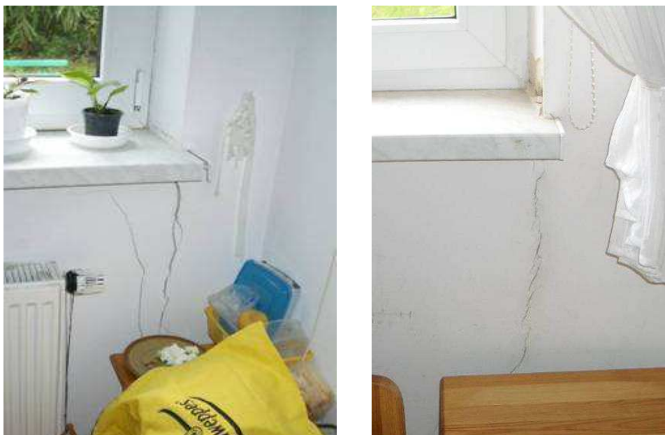
Rys. 8. Przykłady zarysowań pod otworami okiennymi
