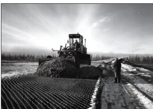
Rys. 8. Zасыpywanie kruszywem komórek geosiatki za pomocą ładowarki
