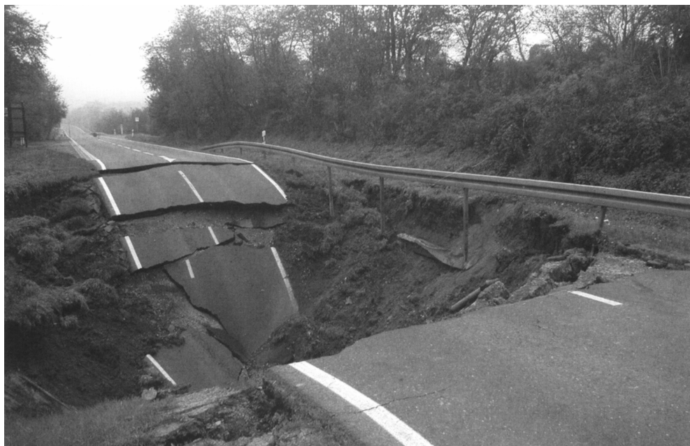
Rys. 16. Przykład zniszczenia drogi spowodowanego zapadliškiem [59]
