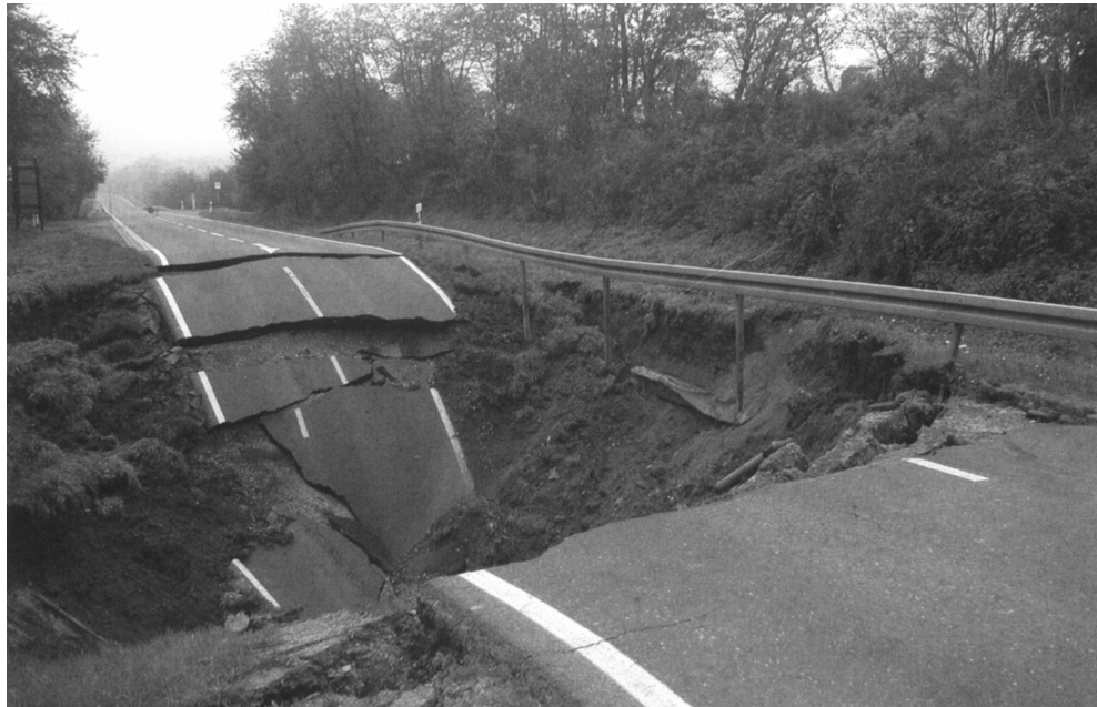
Rys. 16. Przykład zniszczenia drogi spowodowanego zapadliskiem [59]
