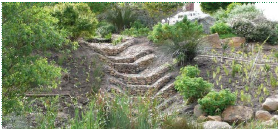
Fot. 5. Płynąca woda lepiej wytraca energię na dnie potoku, czy strumienia górskiego pokrytego gabionem, wyraźnie zmniejsza się w ten sposób zagrożenie powodziowe, a zwiększa przesiąk dogłębowy – retencja wody (źródło: www.ecogabion.co.za ) https://www.ecogabion.co.za/resources/gabion-g.JPG
