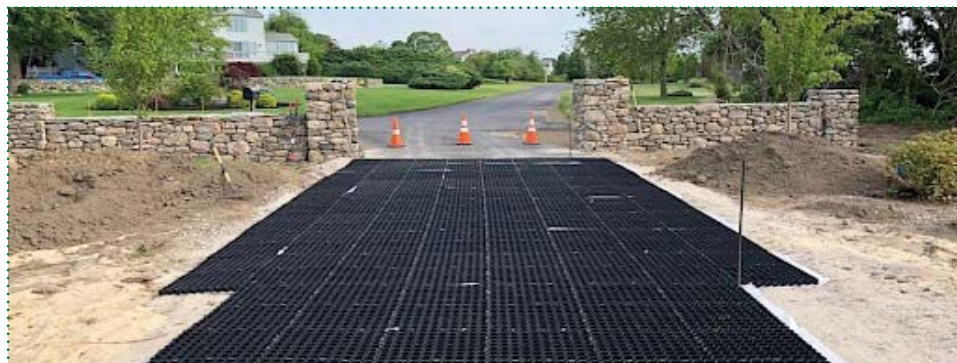
Fot. 7. Tak to wygląda przed wypełnieniem żwirem
