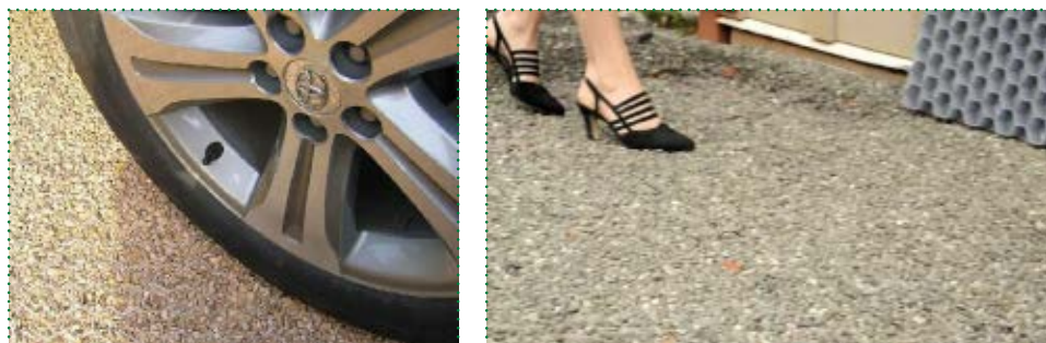
Fot. 9 i 10. Technologia rdzeni żwirowych nie utrudnia ruchu, nawet w szpilkach
