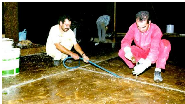
Układanie uszczelki pęczniejącej w istniejącej szczelinie dylatacyjnej.
